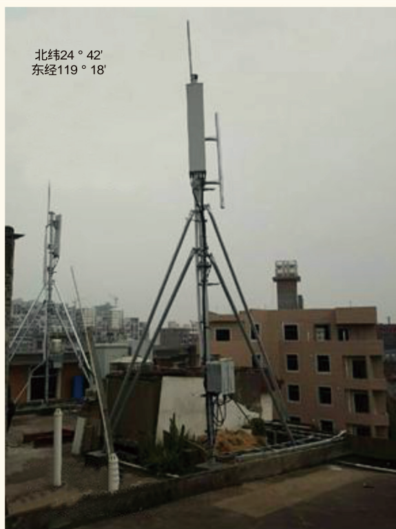
图5 加固后的屋面立杆
