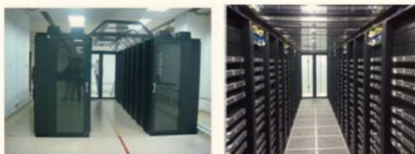
(a) 水泥地面安装
