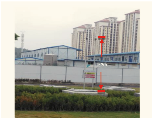
图1 油库正上方不锈钢呼吸孔高度达3m以上
