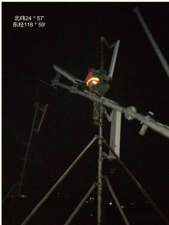
图4 台风中的屋面立杆
