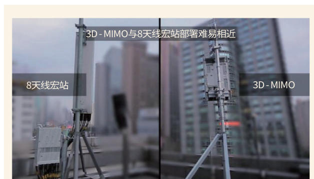
图1 3D-MIMO和8通道天线部署示意
