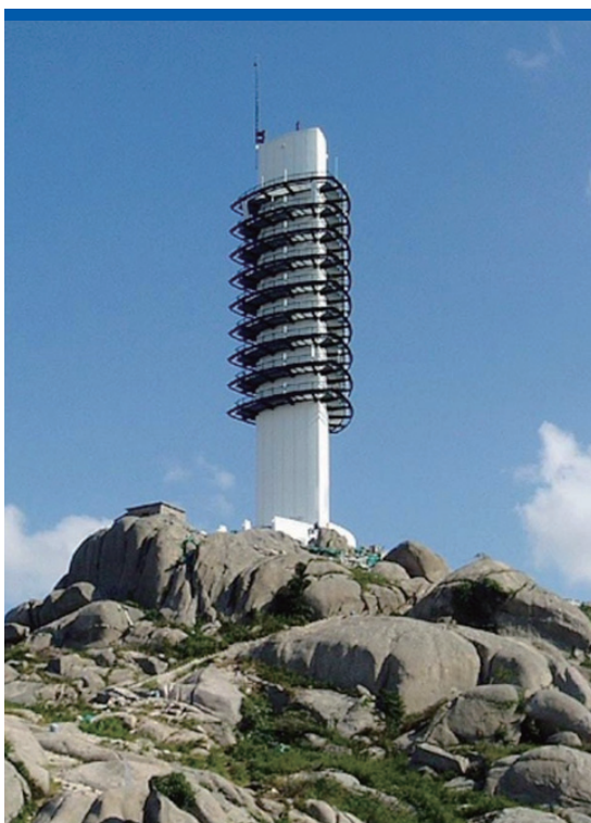
小洋山综合通信塔及雷达站
