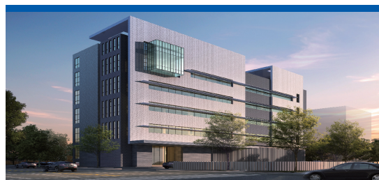
某信息安全数据中心
