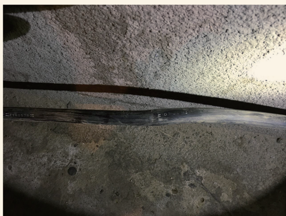
图1 796m处发现有明显的光缆折痕
