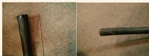
图5 断纤处的光缆外护套明显受到外力挤压
