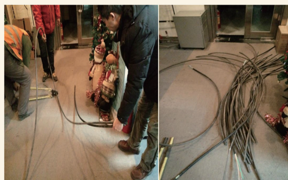
图3 逐段剪断，分段测试
