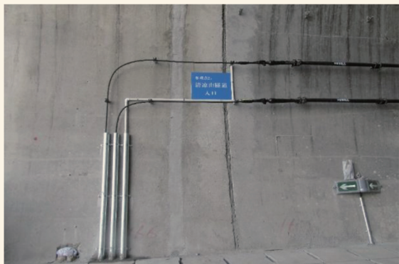
图1 泄漏电缆安装
