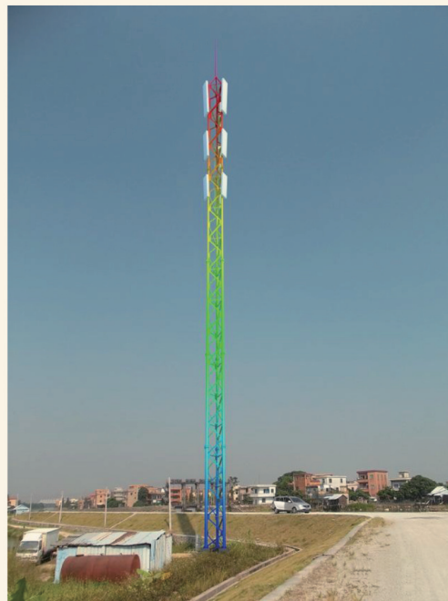
图3 格构式三管塔立面图示意
