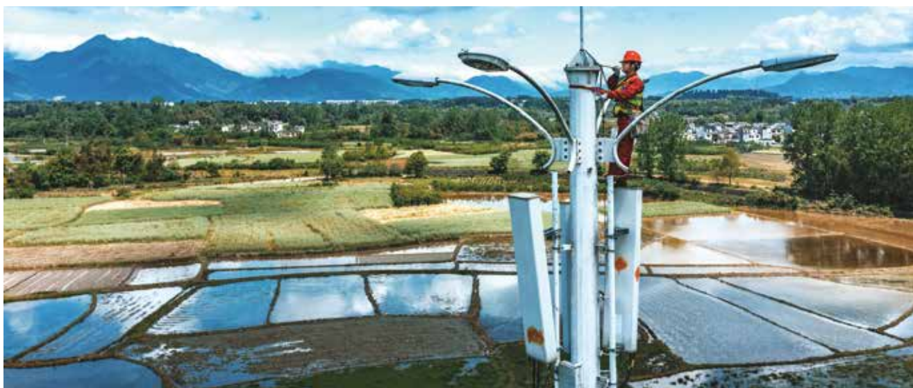
黄山铁塔工作人员对基站进行维护检修
