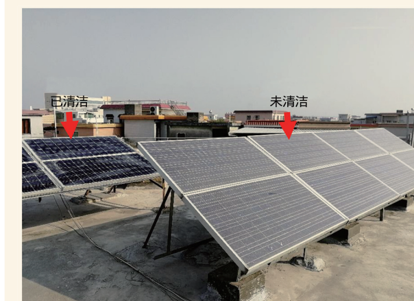
图6 灰尘覆盖的太阳能板
