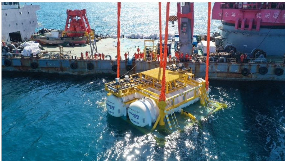
图 20 全球首例商用海底数据中心入海瞬间
