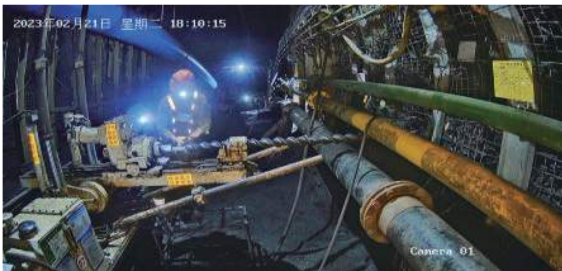
图 6-5 防冲卸压施工现场
