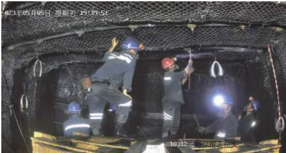
图 6-7 防冲卸压施工现场
