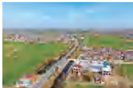
修建安徽省利辛县刘圩村道路
